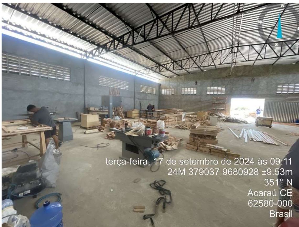
Figura 01: Maquinário e trabalhadores operando.
