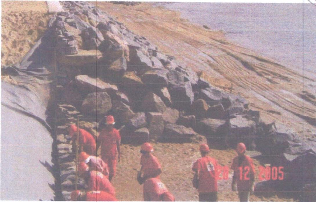
Figura 24 – Exemplo de um enrocamento aderente de blocos graníticos já instalado na Praia de Ponta Negra/RN.
